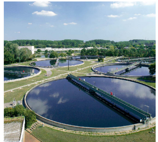
Blick auf die Kläranlage in Ludwigshafen
